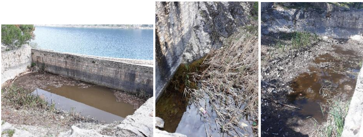
Slike 39., 40. i 41. Stanje lokve nakon čišćenja bagerima i pumpama.
